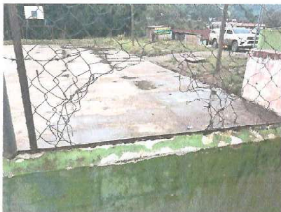
Foto 3: La pintura del muro perimetral se encuentra deteriorada, parte interior.
