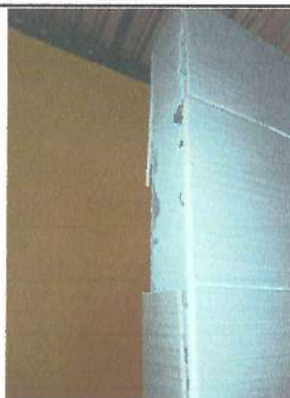
Foto 7: El azulejo de las paredes de los servicios sanitarios se encuentra en mal estado.
