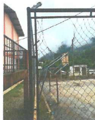
Foto 8: La malla del muro perimetral se encuentra dañada.
